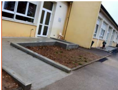
Le groupe scolaire En Saint Jacques a été équipé de sanitaires, rampes et signalisation PMR.
