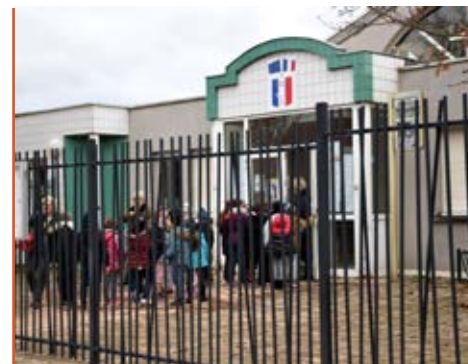
Les clôtures de chaque groupe scolaire ont été renforcées, modifiées ou totalement remplacées.
