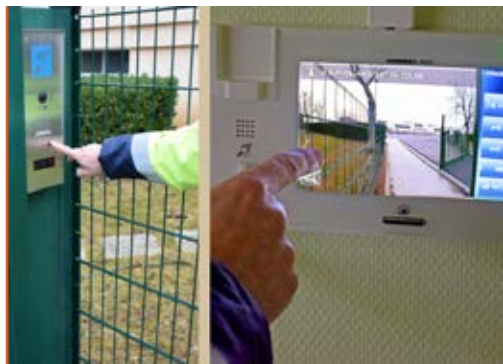
L'installation d'interphones associés à des écrans vidéo permet le contrôle des entrées en dehors des horaires d'école.
