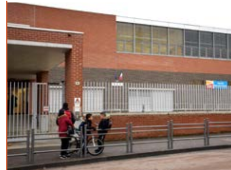
Les nouvelles barrières de sécurité installées au collège Herriot (côté sud) assurent une meilleure sécurité des collégiens aux moments des entrées et sorties.
